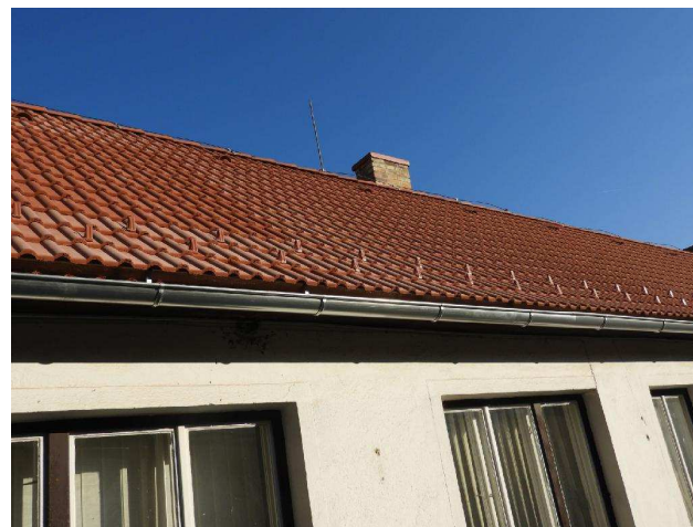
Stav po dokončení realizace:
